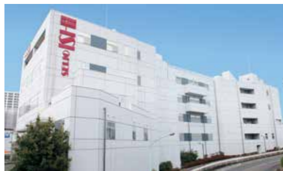
2004年、本格的な設備を導入して建設された、東京都町田市にあるセントラルキッチン
